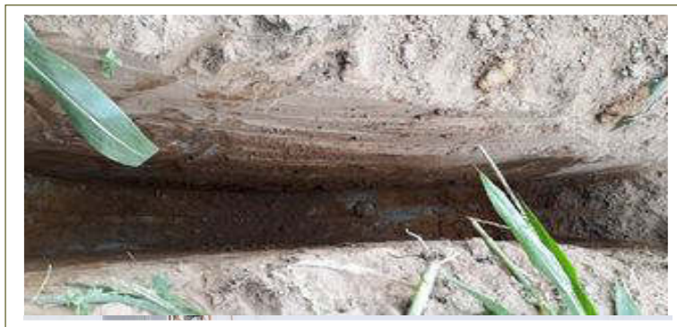
Etude géotechnique : fouille à 3m sur E5
