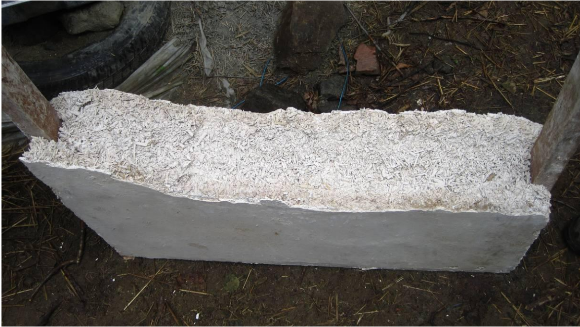
Figure 3.3 : Apparence d'un mur construit à l'aide de la technique « Canalliance »
