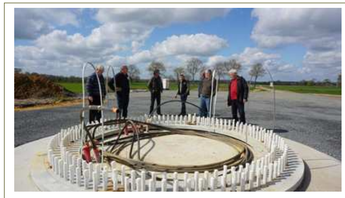
Une délégation d'EOLA visite le nouveau parc éolien citoyen d'Atout Vent, en construction près de Chemillé
