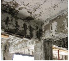
La purge du béton sous les pilotis, 2010-2012.
