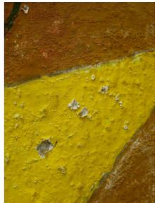
**Efflorescences salines, détail de la peinture du coin salle à manger, photo 2006.**
